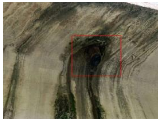
图 3-17: 塔前 2 号大桥(下行) 2-5T 梁: 距 1 号墩 15m 处, 左翼缘板剥落; 数量: 1 处, 长度: 0.2m, 宽度: 0.2m。
